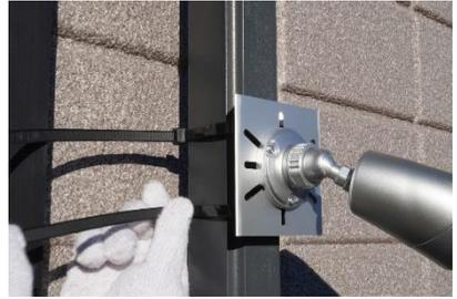
④ 適切な高さ、向きで結束バンドを締め固定する
