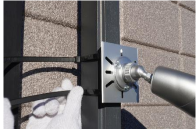
④ 適切な高さ、向きで結束バンドを締めて固定する
