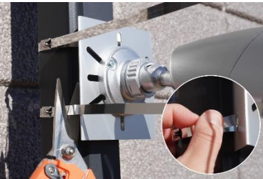
⑤ 結束バンドの余りを金切りばさみ等で切り落とし、スリットに差し込む
