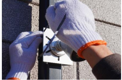
④ 適切な高さ、向きで結束バンドを締めつけて固定する
