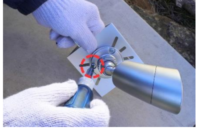
② 付属のねじを使って適切な向きで取付金具に機器を固定する
