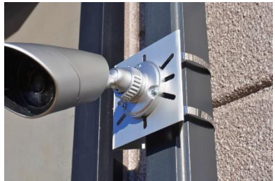
⑥ 緩みがないことを確認して完成
